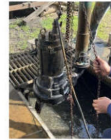
รูปภาพ การดำเนินงานซ่อมบำรุงรักษาเครื่องจักรกลของระบบบำบัดน้ำเสียส่วนกลางนคร
